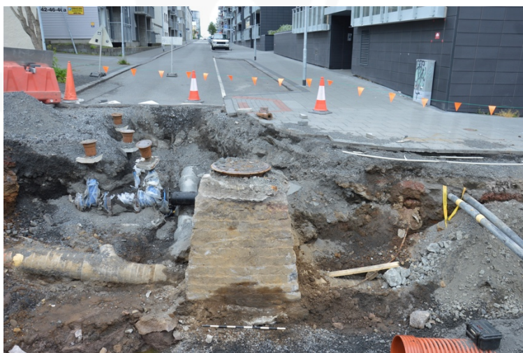
Mynd 1. Fráveitubrunnur á gatnamótum Lindargötu og Frakkastígs (Mynd tekin í V)
