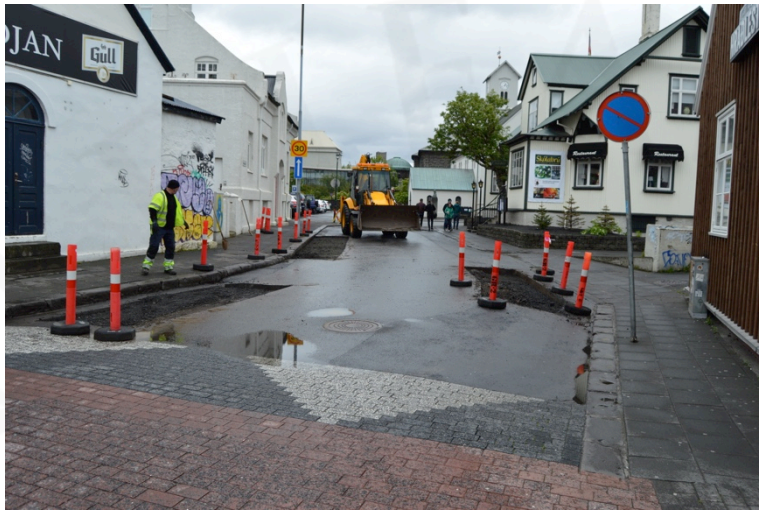
Mynd 1. Skólabrú, á þessari mynd er búið að fjarlægja malbik af skurðstæðunum. (Mynd tekin í V)
