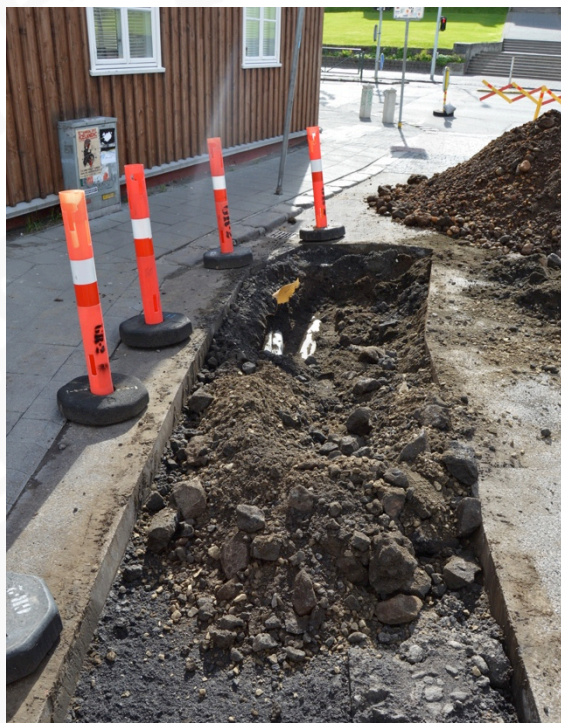
Mynd 10. Skurður 3, í skurðinum sjást lagnir sem ekki var hægt að fjarlægja (mynd tekin í A)
