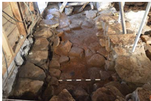
Mynd 15 Steinhleðsla undir viðbyggingu ásamt steinhleðslu sem tilheyrir eldri byggingu. Kjallari steinhússins er hægra megin á myndinni. (Mynd tekin í ANA)
