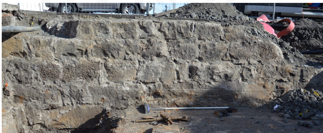
Mynd 9: Norðurveggur séður innan frá. Steypugólfíð er ca. 2m frá vesturveggnum. Engin mannvistarlög fundust í undir steypugólf í könnunarskurði [068]. Búið er að raska veggnum mikið á vesturenda og fyrir miðju vegna lagningar hita og háspennulína.
