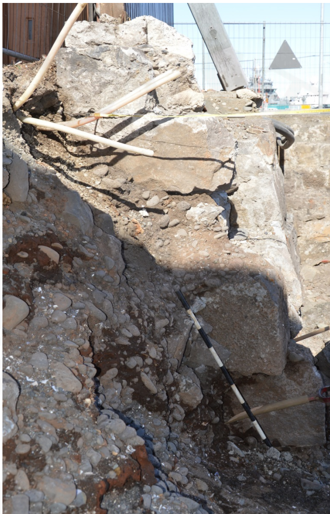
Mynd 14: Suðurhlið vesturveggjar. Lagnir í þeim skurði sem gerður var þegar veggurinn var reistur. Myndin er tekinn í norður. Veggurinn sker móðskulög sem eru í sniði [019].
