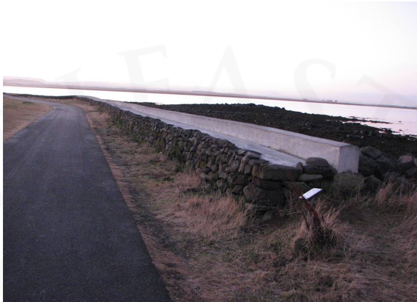
Mynd 5: Garðurinn að verki loknu. Horft í suðvestur.
