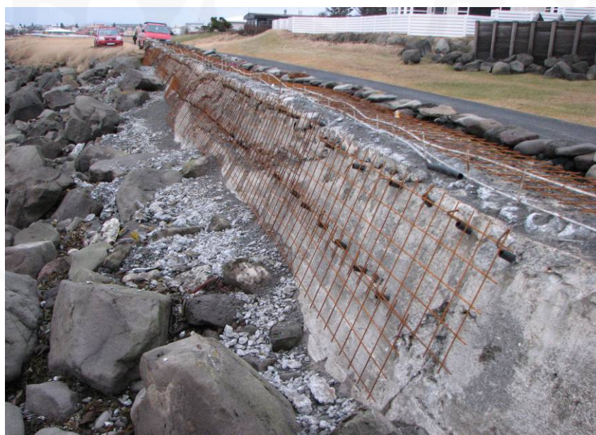
Mynd 4: Járnabinding langt á veg komin. Horft í norðaustur
