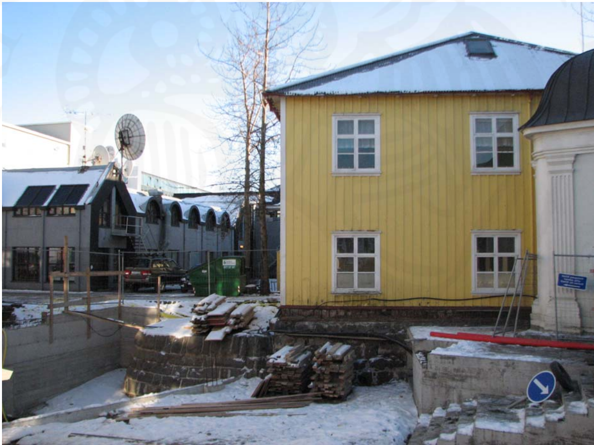
5. mynd. Steinhlaðin undirstaða Vesturgötu 2 og steinhlaðið bólverk norðan þess húss.
