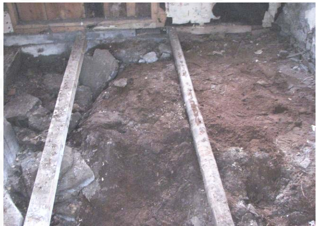
Mynd 8: Horft yfir uppgraftarsvæðið í norðurhluta hússins. Skurður vegna uppsteypu á veggjum hússins er á vinstri hönd.
