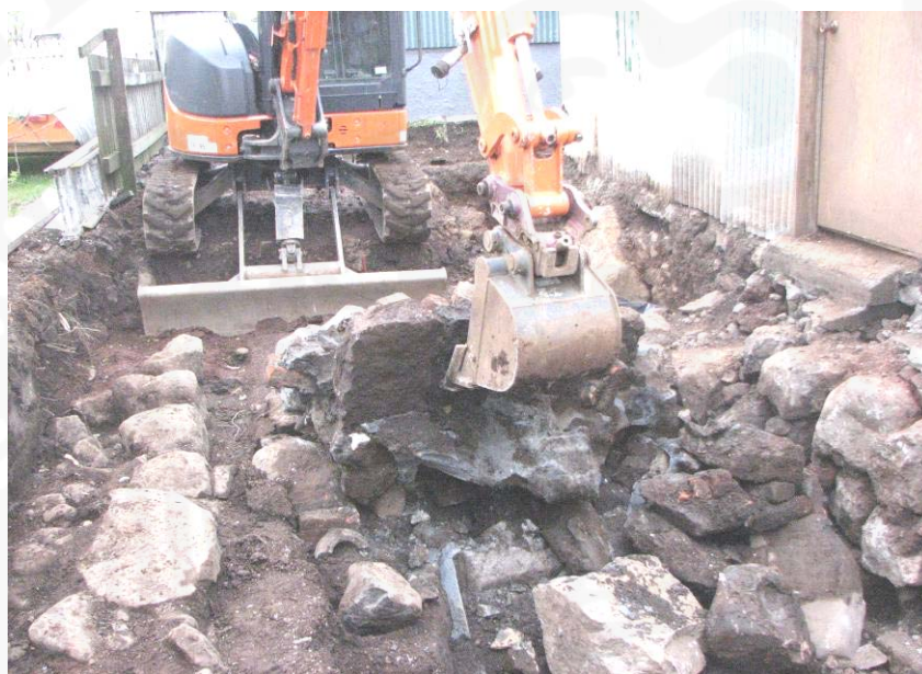
Mynd 4: Skurðgrafan að störfum austan við húsið. Horft í suður.
