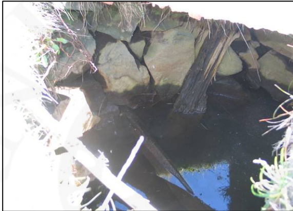
Séð ofan í brunn 017, horft til suðausturs
