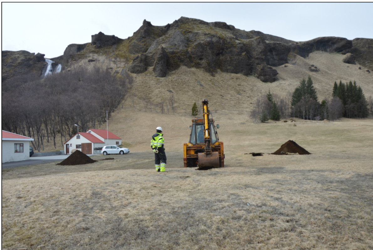
Mynd 5 Uppgröftur hafinn við skurð 3. Horft til norðurs.
