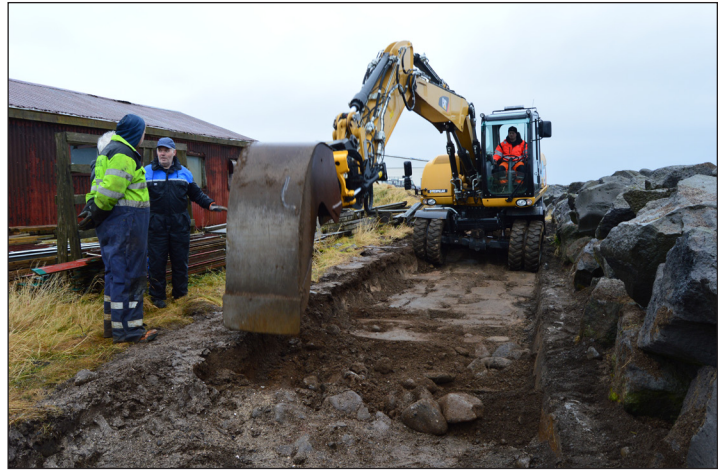
Þegar búið var að skrá mannvirkið var fylgst með á meðan klárað var að grafa fyrir göngustígnum.
