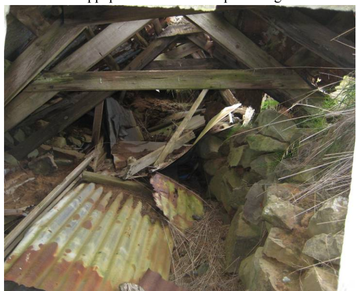
Hesthúsið horft inn (til suðurs)
