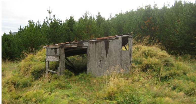
Hesthús 141:021, horft til austurs. Hesthúsið var fyrir 6-8 hesta, byggt eftir 1950.
