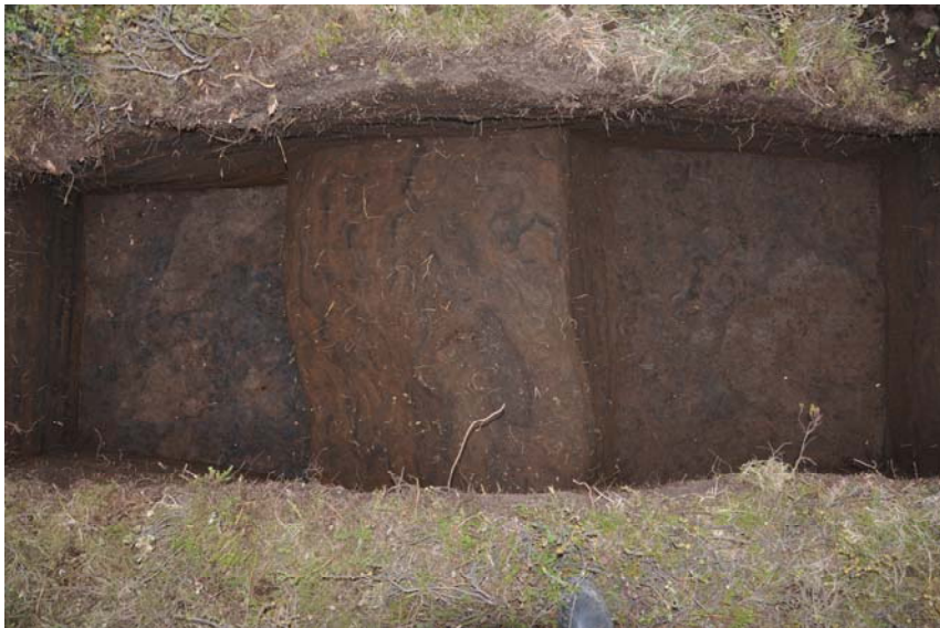
Mynd 2: Veggur í skurði 1
