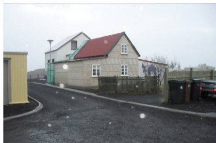
Mynd 11 Guðbrandarbær, horft til norðausturs
