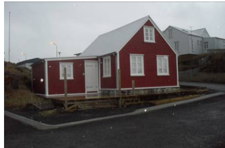
Mynd 10 Magnúsarhús, horft til vesturs
