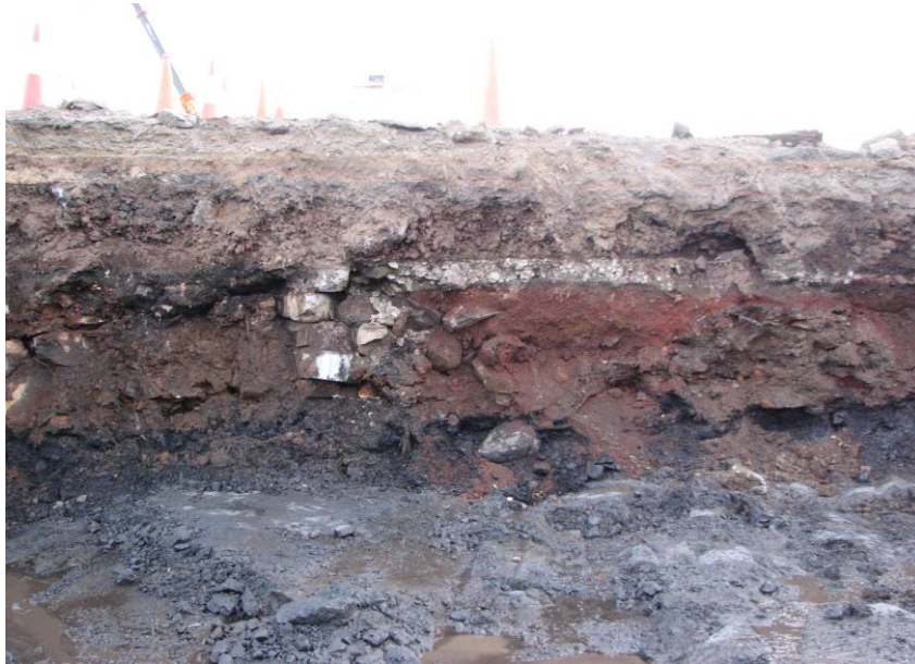
Mynd 4: Hluti af suðursniði vegstæðisins utan við hina náttúrulegu strandlínu. Má þar greina þar grjótsökkul og steypa plötu frá 20. öld.
