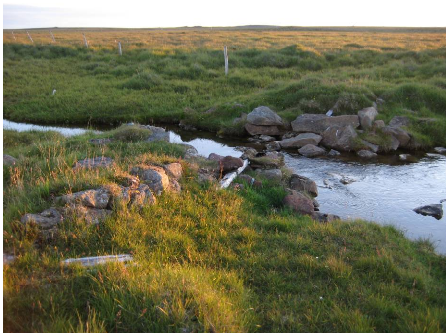
Ljósmynd 36: Brú þar sem vegur NP-062:044 liggur yfir Steinboga. Horft í suðvestur
