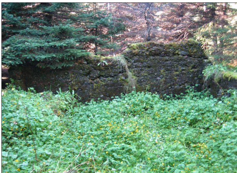
Steyptur útveggur í Skarðdalskoti EY-008:001.
