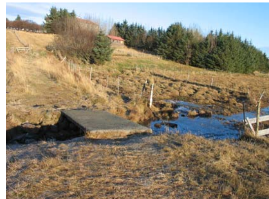
GK-175:010, Vífilsstaðalækjarbrú. Horft til norðausturs.
