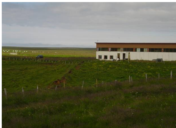
Túngarður sunnan við Sögina hf., horft í norðvestur
