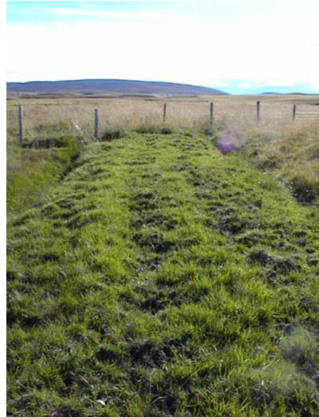
Gamli hreppavegurinn, horft til suðausturs
